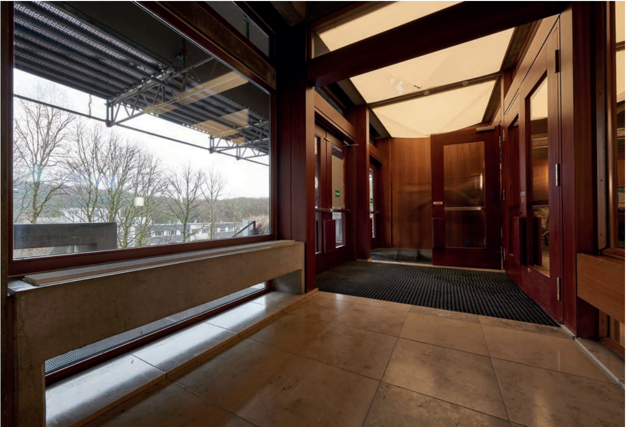
Fig.24 Hintereingang der Mensa mit Schutzgerüst 2018 © Marco Kany
